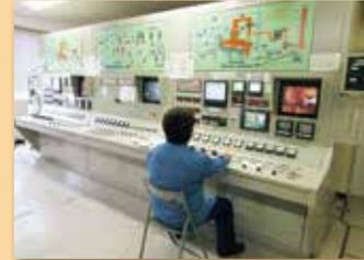
※中央制御室では、焼却炉内の燃焼状態をモニターや各種計器類により監視し、常に最適な状態で燃焼するよう管理しています。
