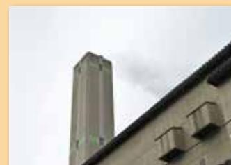
⑨クリーンになった排ガスは、煙突から屋外に放出されます。気温が低い日などは、排ガスが白い煙状に見えますが、これは、施設で使用した水が水蒸気となり、外気によって冷やされるためです。
